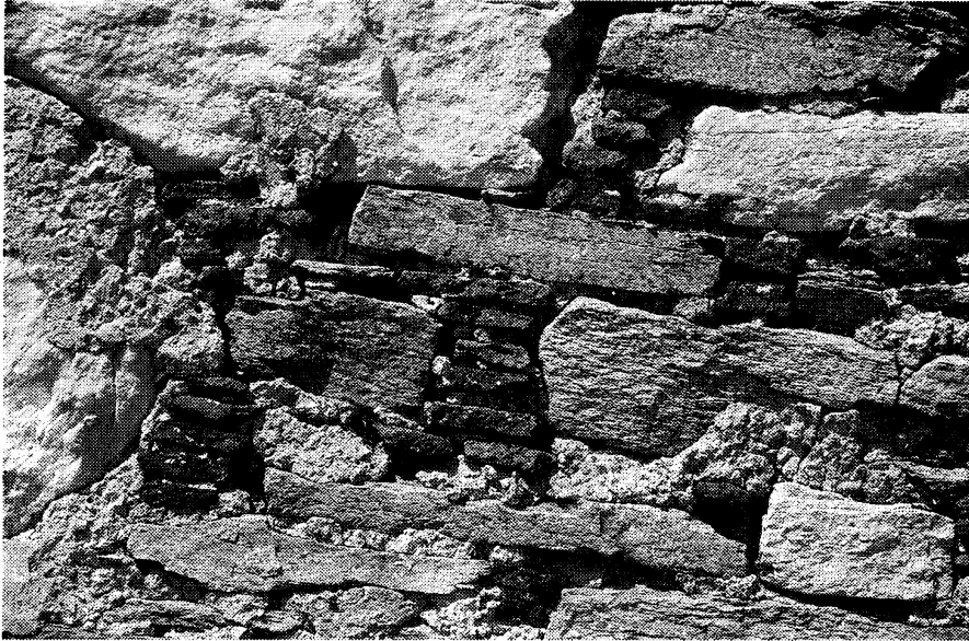
4. Οι τοίχοι είναι κατασκευασμένοι από επιμήκεις ακατέργαστους λίθους γνευσίου και μαρμάρου και οριζόντια τεμάχια πλίνθων που παρεμβάλλονται σε διάφορες θέσεις σε επαλληλία. (Φωτογραφία του 1999).
