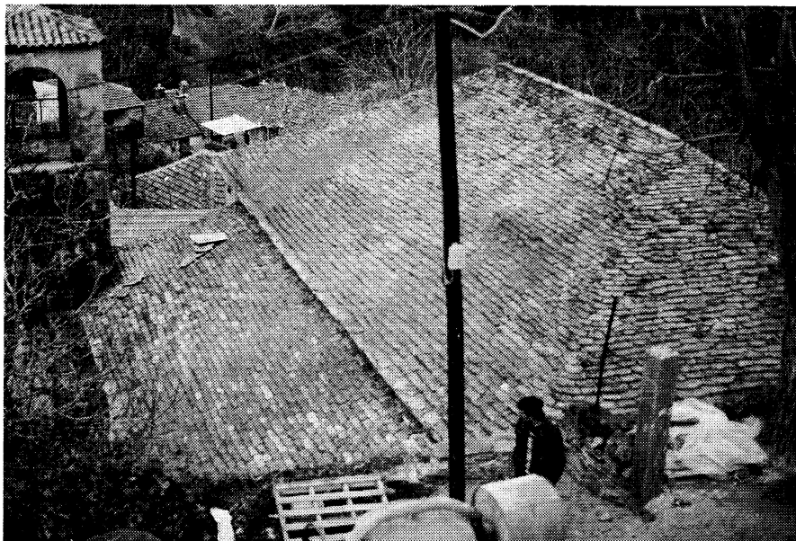
Η πλακοσκεπή κατά την επέμβαση και στο πέρας των εργασιών.
