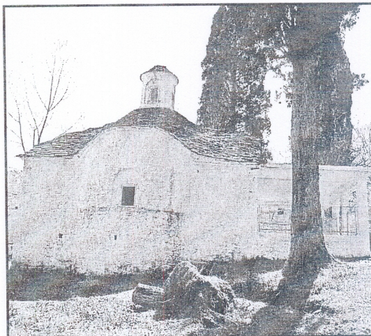
Φωτ. 11. Βόρεια όψη.
