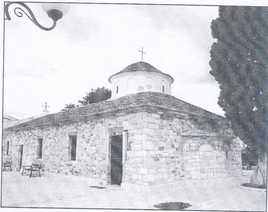
Εικ. 1. Ο ναός του Αγίου Νικολάου. Αποψη από ΒΑ. Η διαμόρφωση της ανοικτής πλατείας άλλαξε τη σχέση του ναού με τον περιβάλλοντα χώρο.
